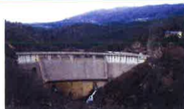
Vue du barrage de Sénéchas (source: BRLi)
