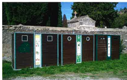
Installation de conteneurs tri selectif quartier du Ranquet
