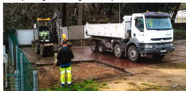
Démarrage des travaux
