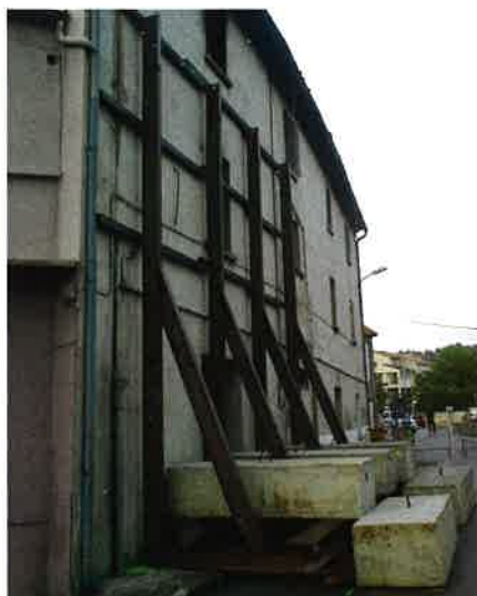
Mise en sécurité d'un immeuble après incendie
