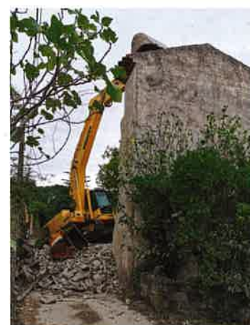
Démolition de la Maison Brès
